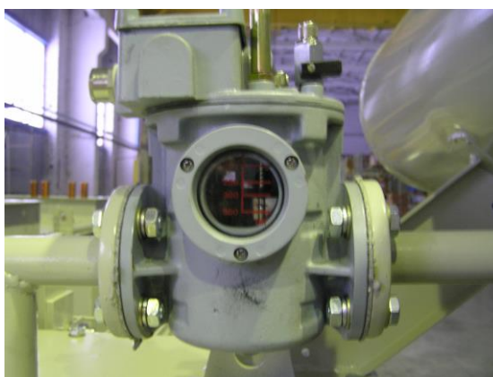
Рис. 7.8 Газовое реле С01Н
